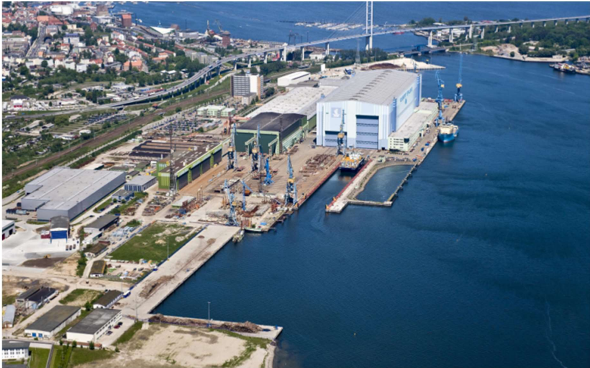
1 Blick auf das Werftgelände Stralsund
